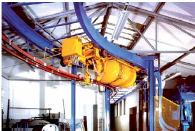
Питание и управление на бетонном заводе
